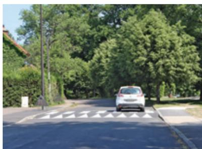
Un plateau surélevé a été installé rue Clémenceau pour ralentir les véhicules et sécuriser la traversée des piétons entre le parc thermal et le parking.
