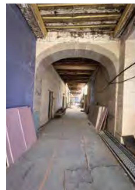
Rénovation de la grande galerie
