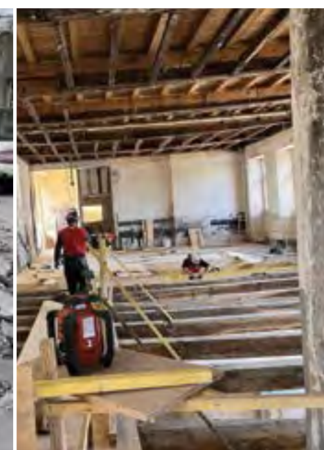
Consolidation des poutres
