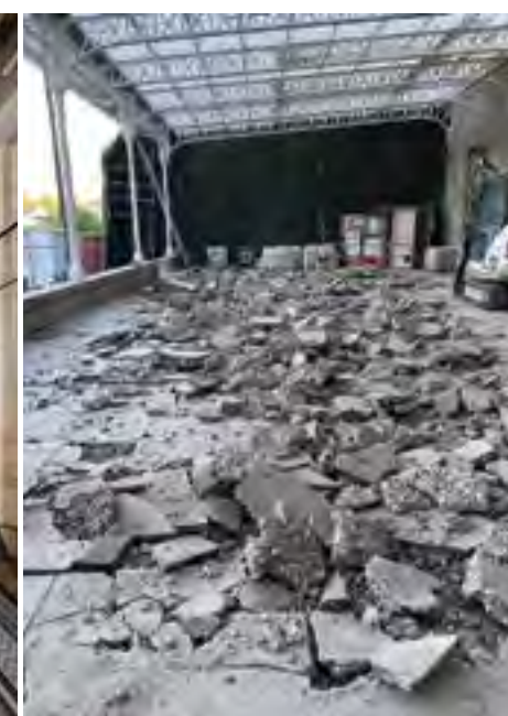
Démolition du sol du péristyle
