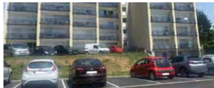
Le nouveau parking des Barrèges avec son revêtement drainant
